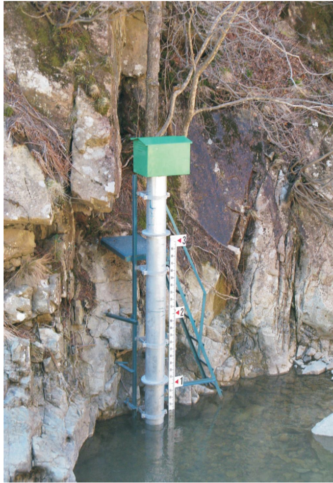
Şekil 3. Debi ölçülmesi amacıyla kullanılan bir akım gözlem istasyonu (Anonim, 2011b)
