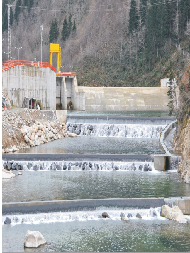
Şekil 4. Regülatör mansabında yapılan akarsu yatağı düzenlemesine bir örnek (Anonim, 2011b)
