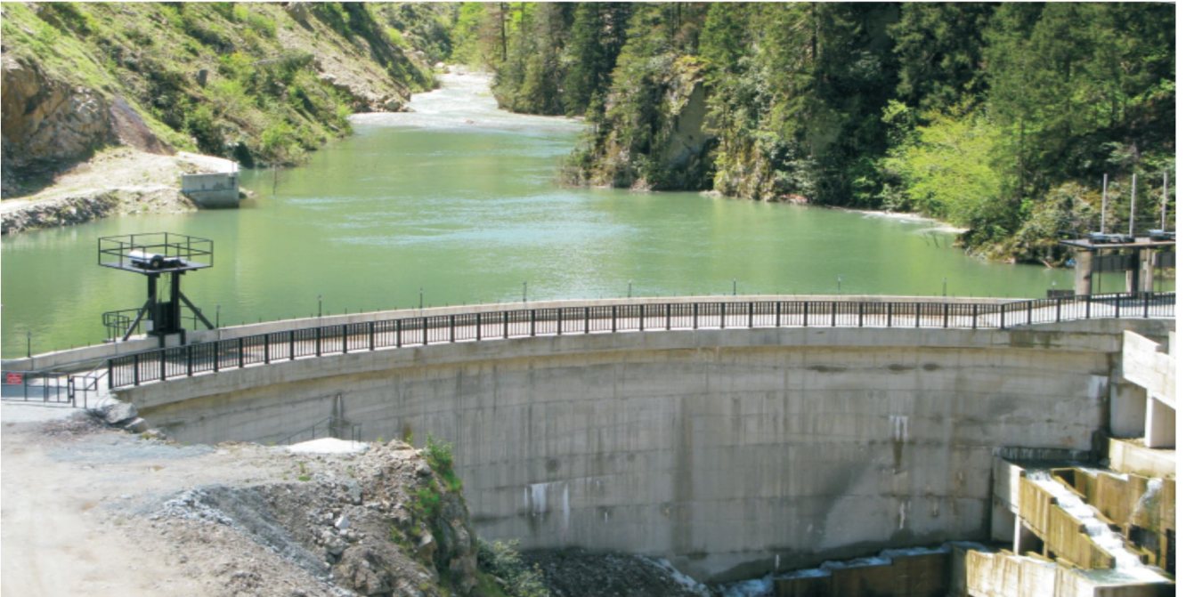
Şekil 1-2. Balık geçidinin inşaatı ve çalışmasına uygun olan tirol tipi regülâtör yapısı (Hayrat İlçesi/solda) ve balık geçidi inşaatı daha karmaşık ve zor olan baraj tipi regülâtör yapısı (Çaykara İlçesi/sağda) (Anonim, 2011b)
